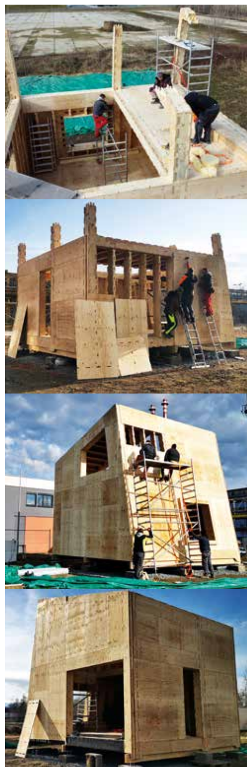
▲ Stavba experimentálního domu ecokit ve spolupráci s UCEEB ČVUT. Dům bude sloužit k podrobným měřením teplot a vlhkosti v konstrukci a vnitřním prostředí po dobu 12 měsíců.
